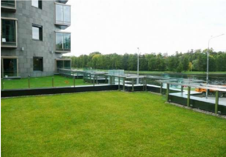
Рис. 4. «Зеленая» кровля в ЖК Diadema Club House в Санкт-Петербурге (Россия) [17]
