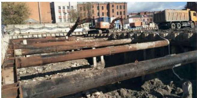
Рис. 2. Площадка строительства по адресу Санкт-Петербург, Аптекарский проспект
