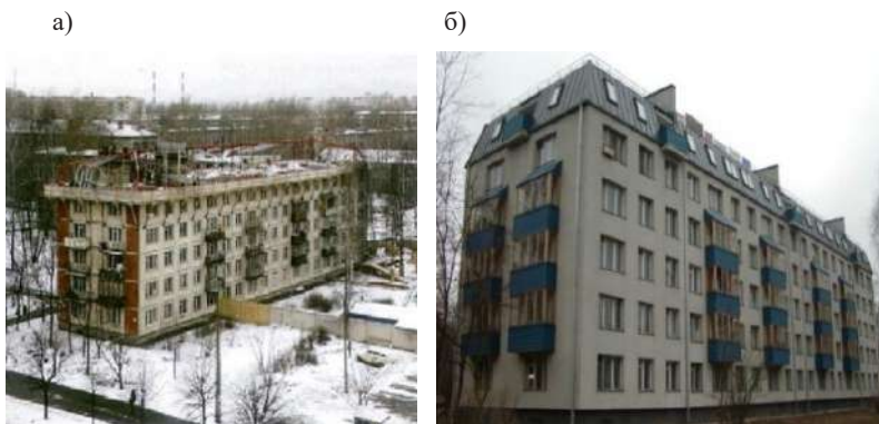
Рис. 4. Реконструкция пятиэтажного жилого дома: а – выполнение работ по надстройке; б – эксплуатируемое здание после реконструкции
