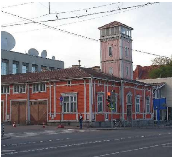
Рис. 5. Пожарное депо. Арх. Б. Аминов, 1888 г. Ул. Карельская, 15. Фото: tripadvisor.ru
