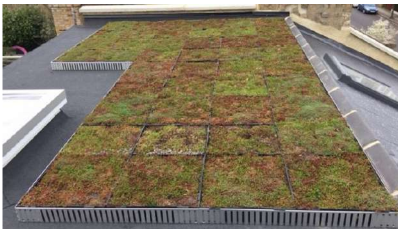
Рис. 1. Устройство модульной системы «зеленой» кровли [14]
