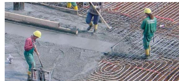
Рис. 1. Замоноличивание полиэтиленовых труб
