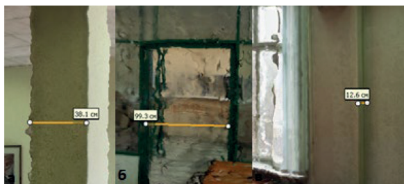
Рис. 4. Указания на чертеже расположения и размеров: а) колонны; б) дверного проёма; в) стенового выступа (пилястра)
