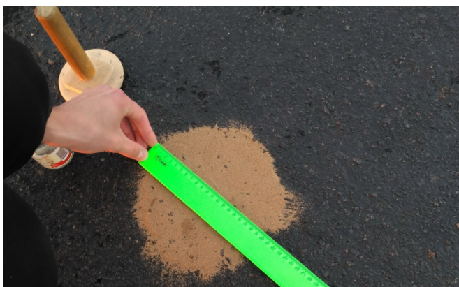
Рис. 3. Контроль сцепных качеств покрытия методом «песчаное пятно»
