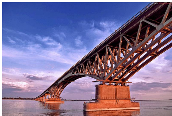
Рис.1. Железобетонный мост Саратов–Энгельс
