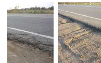
Рис. 3. Превышение кромки проезжей части над обочиной федеральной дороги М-7
