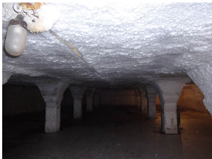
Рис. 3. Вид помещений подвала в осях А-И/1-4 (лит А)
