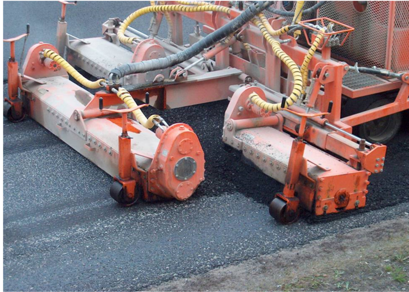
Рис. 6. Технология производства работ методом Новофлекс.
