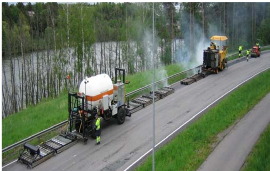
Рис. 5. Технология производства работ методом УраРемо.
