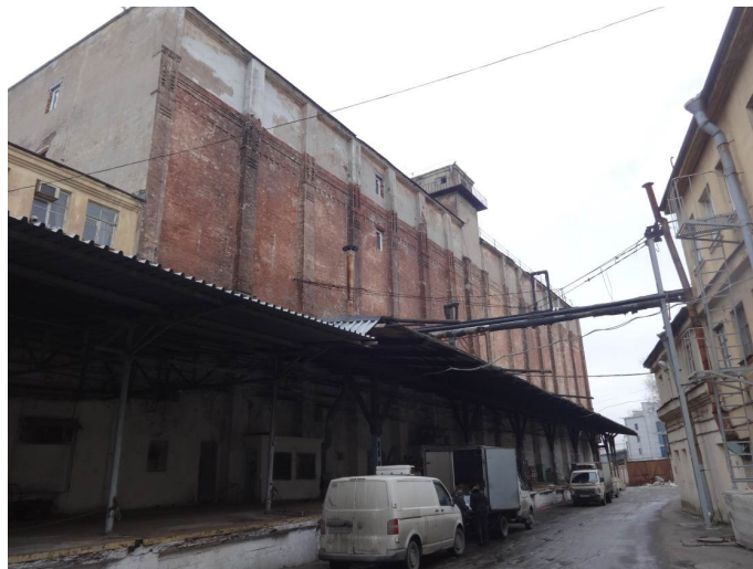
Рис. 2. Фасад здания в осях Ц-А (лит А)
