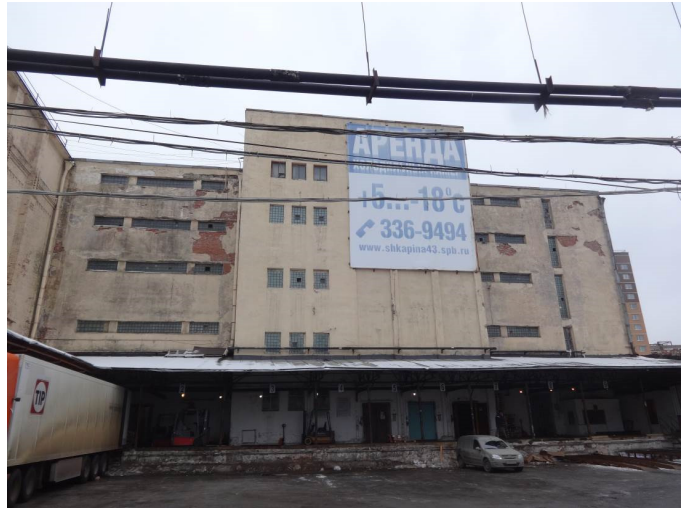
Рис. 1. Фасад здания в осях 7-18 (лит Б)
