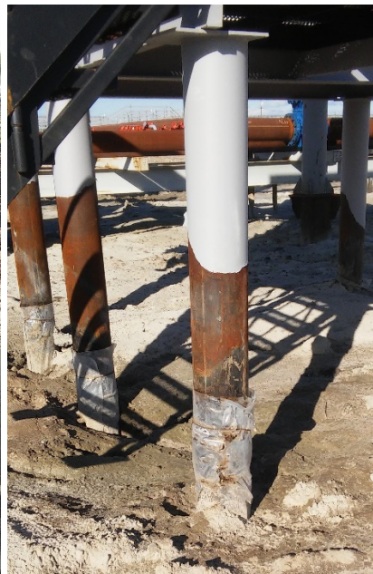
Рис. 4. Противопучинная защита свай:
