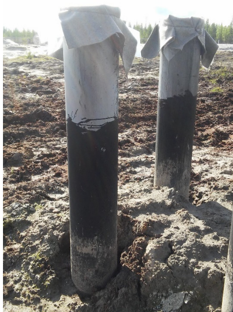
Рис. 4. Противопучинная защита свай:
