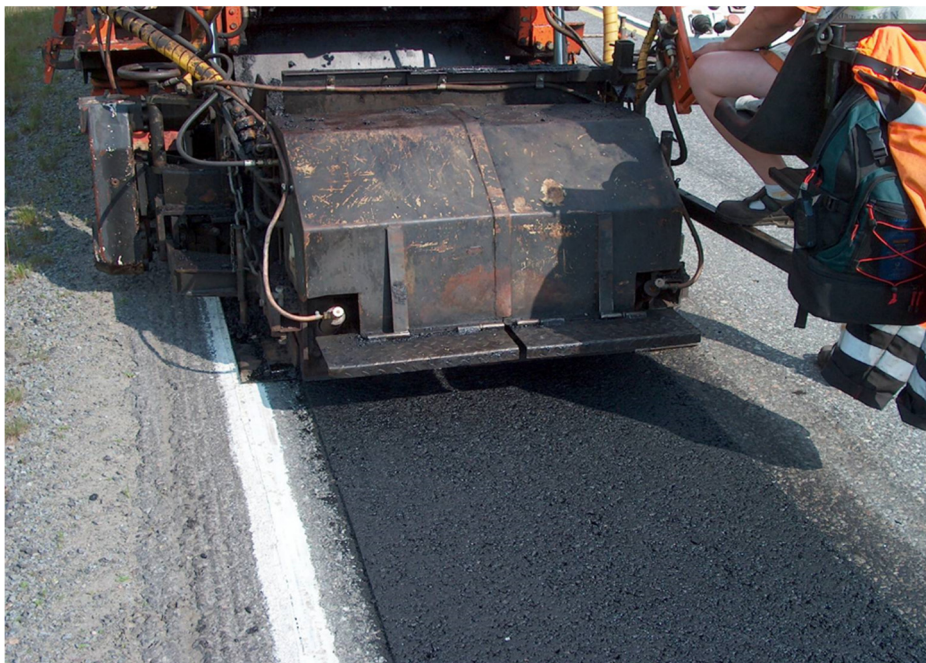
Рис. 4. Технология производства работ методом ремикс колеи
