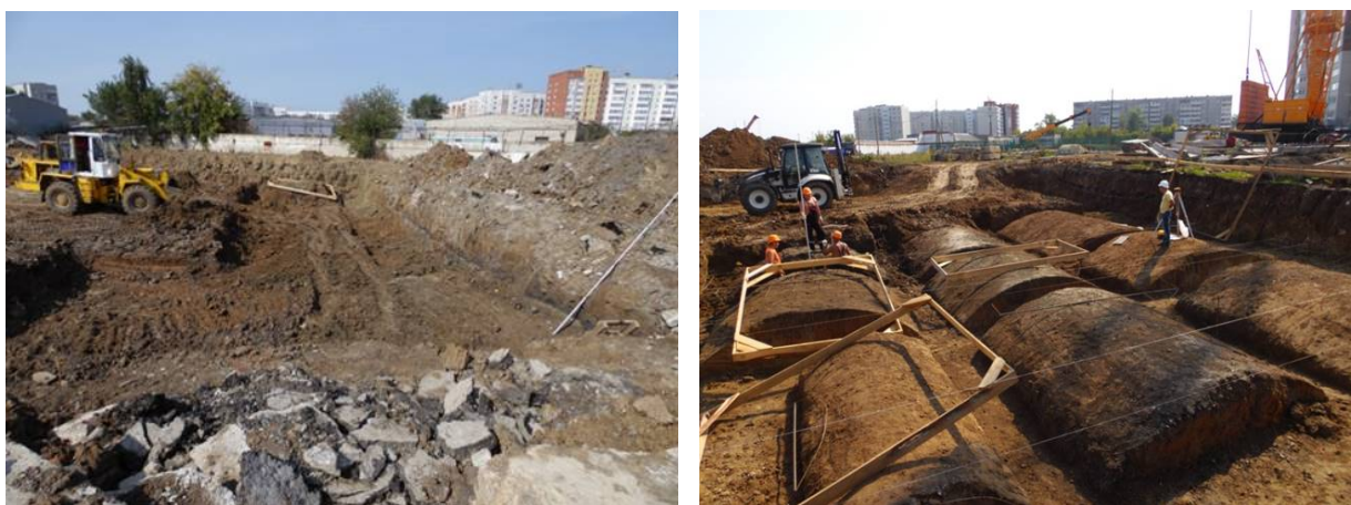
Рис. 6. Разработка грунта в котловане и формирование цилиндрического основания грунта под оболочки
