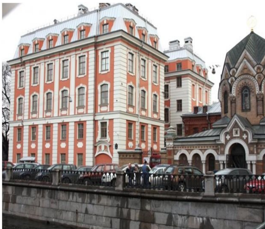
Рис. 2. Пример быстровозводимых технологий на основе комплектов стальных каркасов и легких сэндвич-панелей полной заводской готовности для реконструкции. Реконструкция охранного исторического объекта КГИОП 1910 г. «Высшей школы народных искусств» Минобразования РФ, г. Санкт-Петербург, Наб. кан. Грибоедова, д. 2. Демонтаж старого аварийного и монтаж нового мансардного этажа за 1 месяц в стесненных условиях исторического центра, монтаж всех быстровозводимых новых перегородок и перекрытий на всех этажах за 2 месяца
