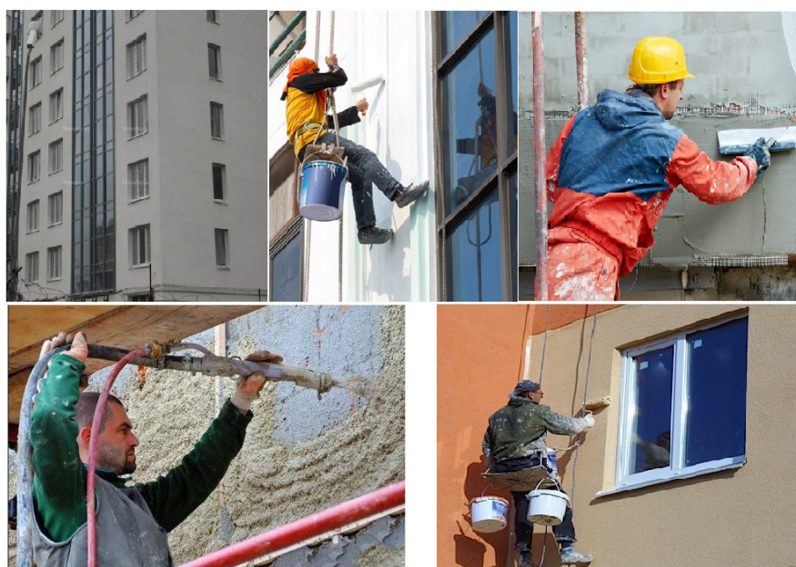
Рис. 1. Существующий «механизированный» способ отделки по технологии «мокрого фасада»
