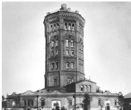
Рис. 5. Водонапорная башня Главной станции городских водопроводов, СПб., 1860–1863 гг., арх. И. А. Мерц
