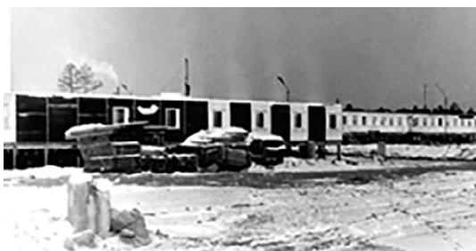
Рис. 4.2. Панорама строительства комплекса быстровозводимых зданий: общежития, кухни-столовой, административных зданий с учебными классами в г. Норильске
