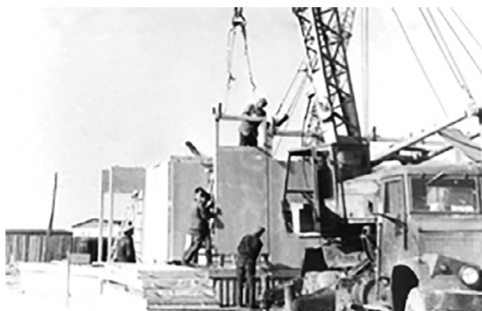
Рис. 4.4. Монтаж панелей стен ячейковой части комплекса
