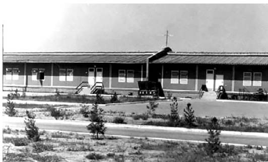
Рис. 4.9. Быстровозводимое общежитие системы «Сокол» для оперативного размещения строителей в районе г. Кировокана
