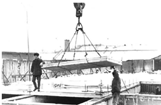
Рис. 4.3. Монтаж панелей перекрытия экспериментального физкультурно-оздоровительного комплекса
