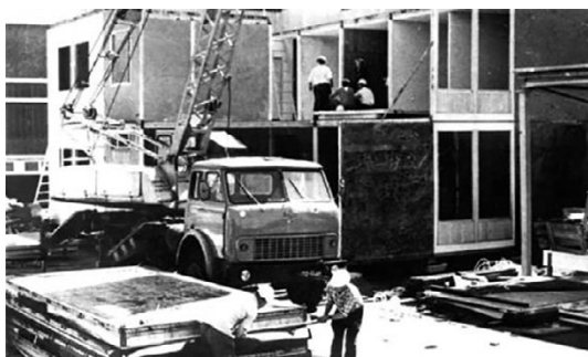
Рис. 4.8. Монтаж двухэтажных жилых домов системы «Модуль» в окрестностях г. Степанавана строителями государственного кооперативного объединения «Леноблагрострой» (Степанаванское специализированное строительное-монтажное управление)
