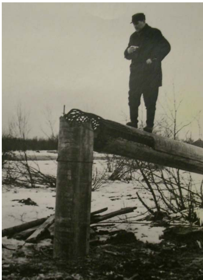
Рис. 3. В. А. Трульв на натуральных испытаниях опоры ВЛ 330 кВ
