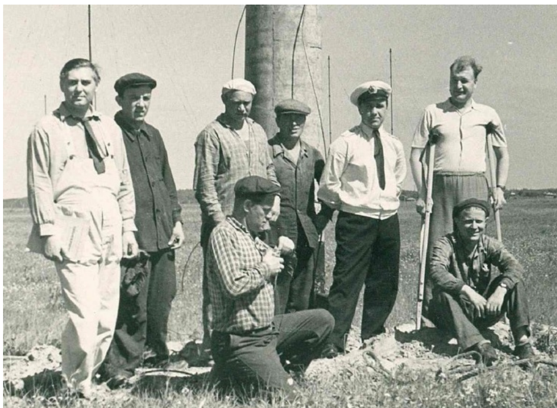
Рис. 3. В. А. Труль (крайний слева) и И. А. Петров (на костылях) на натурных полевых испытаниях восьми железобетонных центрифугированных опор на ВЛ 220 кВ «Сясь – Пикалево» в Ленобласти (1961)
