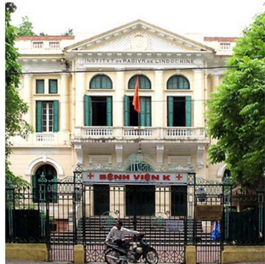
Рис. 7. Здание радиового института Индокитая. Архит. С. Delpech, 1927 г. Задний фасад и центральный фрагмент главного фасада
