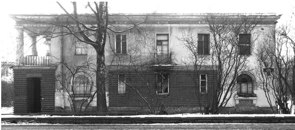
Рис. 7. Общежитие по ул. Крупской д.14 лит. Б. Фасад. Фото 2015 г. Снесено в 2016 г.
