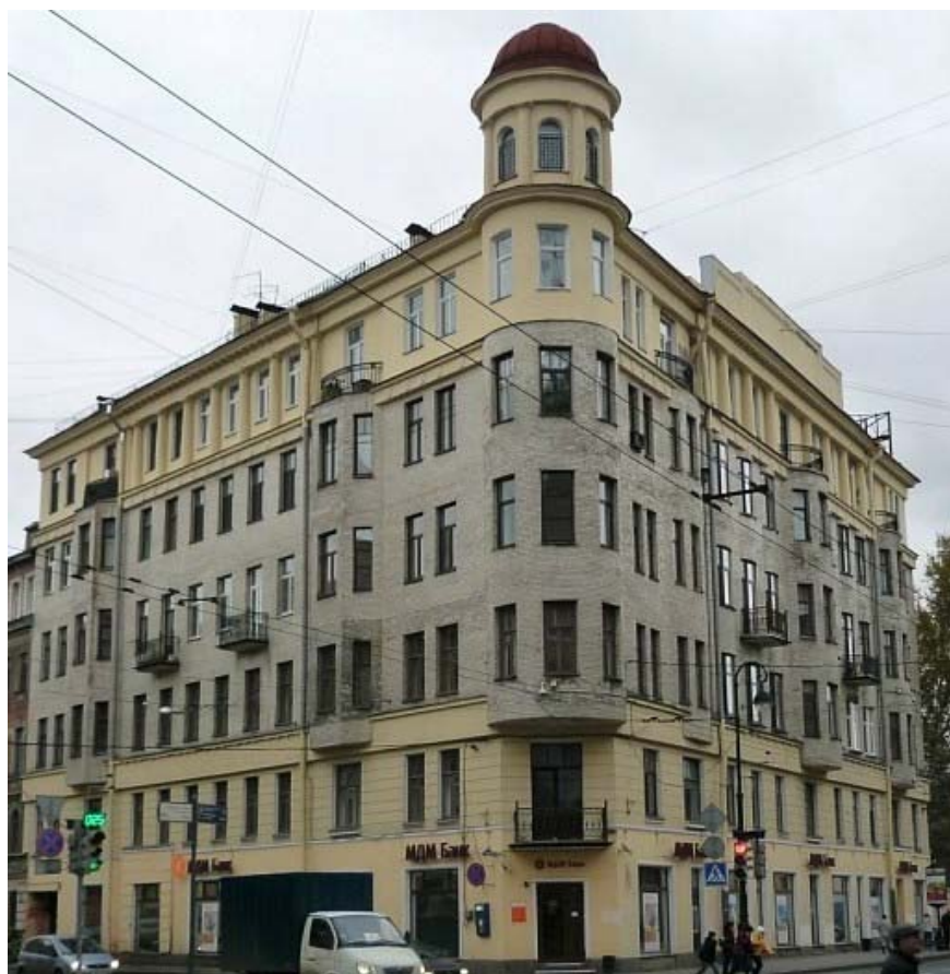
Рис. 6. Каменноостровский проспект, 53. Фото автора, 2016
