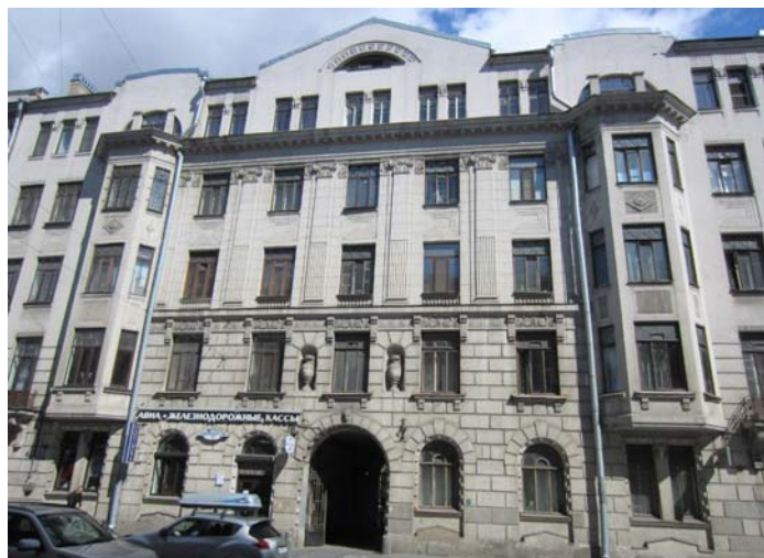
Рис. 1 Каменноостровский проспект, 21. Фото автора, 2016
