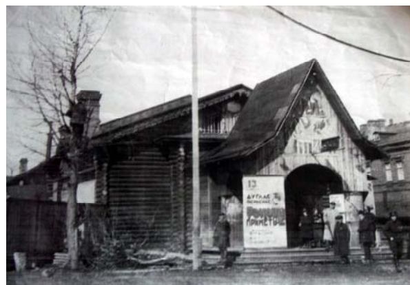
Рис. 4. Деревянная церковь Путиловского завода (после революции кротеатр «Жар-птица»)
