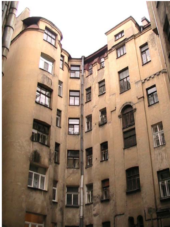
Рис. 7. Каменноостровский проспект, 35. Фото автора, 2016.
