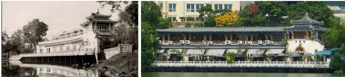
Рис. 21. Здание ресторана «Тху-Та». Архит. Во Дык Зьен, 1937 г.
