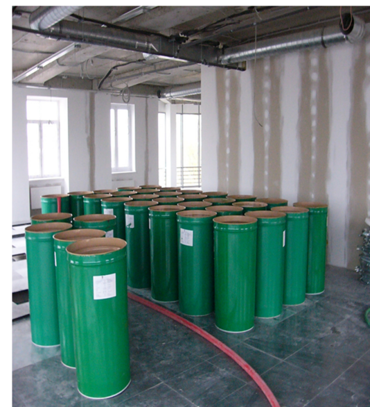
Рис. 11. Создание статической нагрузки на перекрытие
