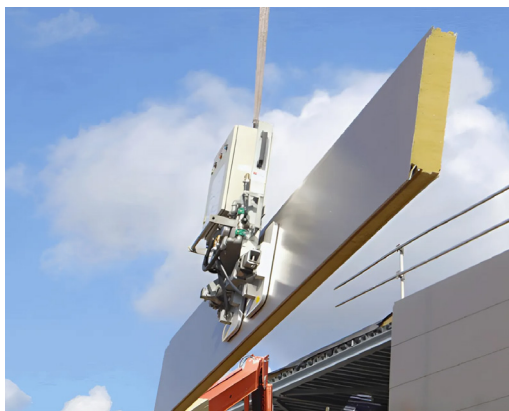
Рис. 2. Вакуумное оборудование для монтажа сэндвич-панелей
