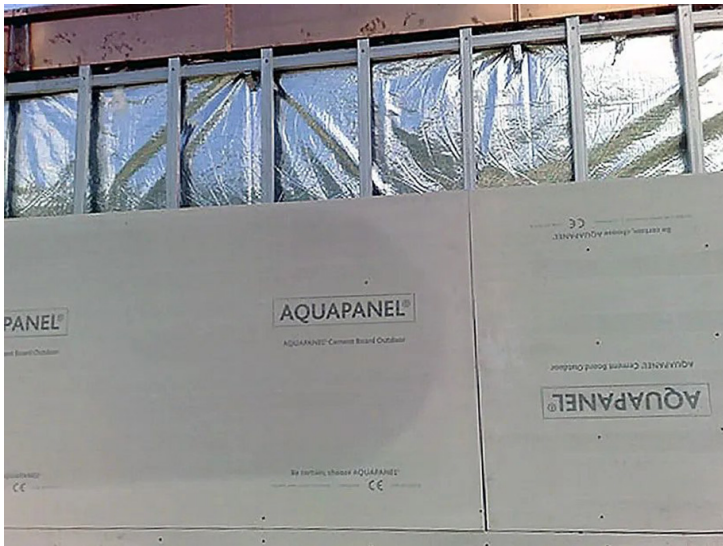
Рис. 2. Часть стены здания с аквапанелями
