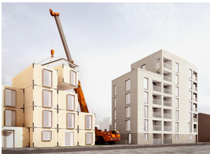
Рис. 1. Строительство здания с применением объемных модульных блоков
