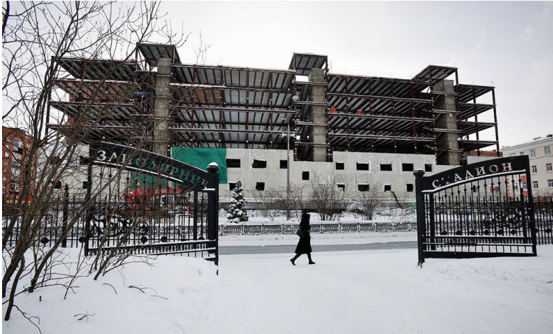
Рис. 3. Шестиэтажное быстровозводимое каркасное здание в условиях Крайнего Севера
