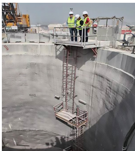
Рис. 3. В проектах туннелей в Абу-Даби используется сталефибробетон для защиты от коррозии
